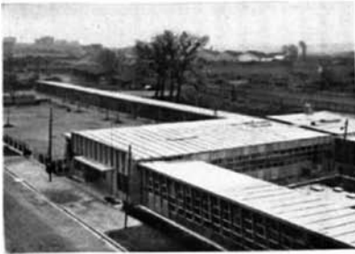
École de la cité Paul-Langeron, à Saint-Denis (Seine) (Paul Obenwald et Gaston Martin, architectes)
