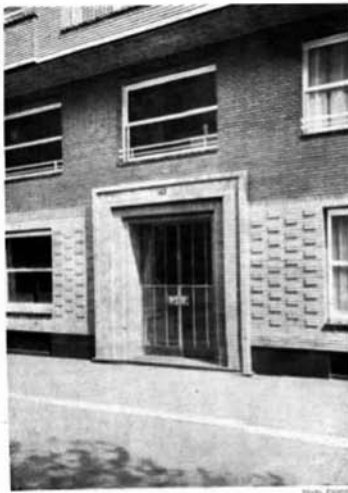
Maison de rapport, boulevard du Montparnasse, à Paris. Dessin de l'architecte Joseph Madeline, architecte D.P.L.G.
